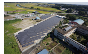
小山太陽光発電所
