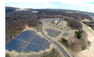
いわき太陽光発電所
