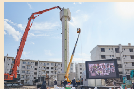
解体工事の様子
