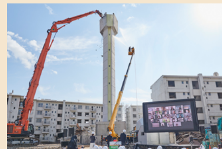
解体工事の様子
