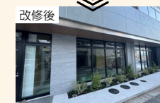
駐車場から店舗へのコンバージョンの様子
