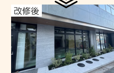
改修後 駐車場から店舗へのコンバージョンの様子
