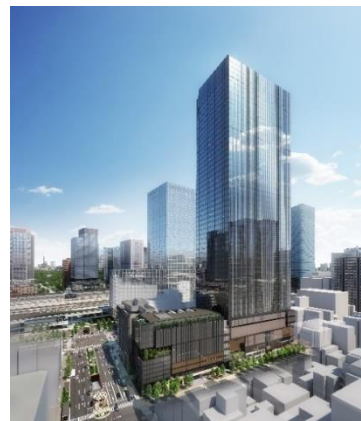
「TOFROM YAESU TOWER」
