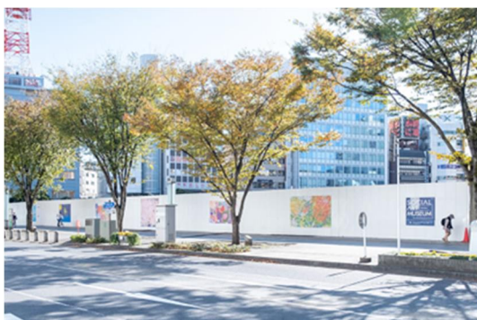
マンション建設現場の仮囲いアート
