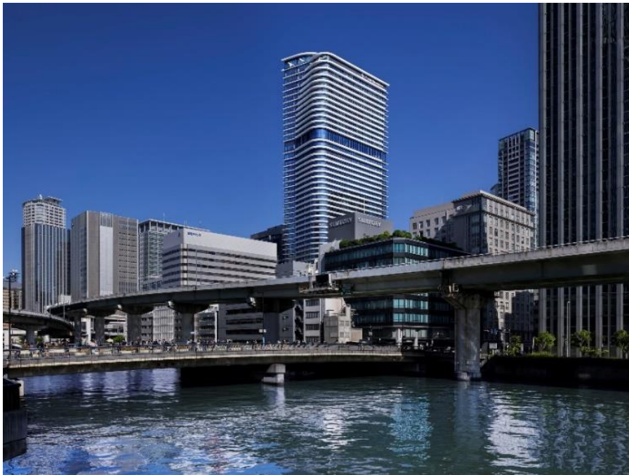
「ONE DOJIMA PROJECT」 外観
