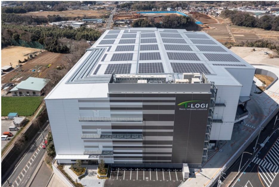
物流施設「T-LOGI」屋根に設置された太陽光パネル（T-LOGI 千葉北）
