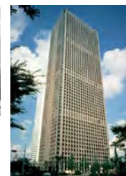
当社の知名度向上と業容拡大に大きく貢献し、西新宿のランドマークとなった新宿センタービル(1979年竣工)
