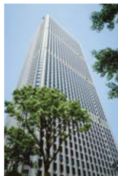
新宿センタービル
