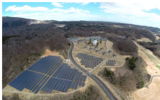
いわき太陽光発電所(全体)
